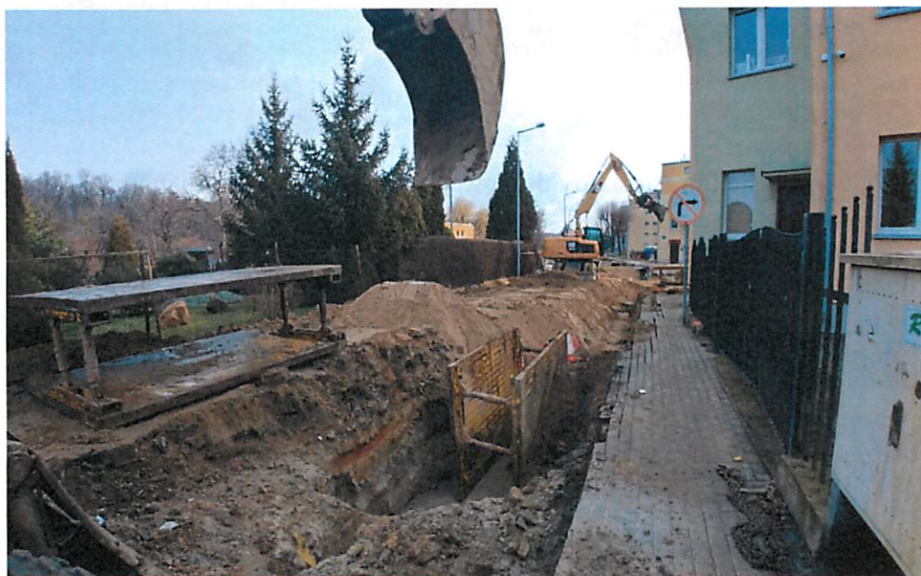
Prace przy ulicy Ogrodowej
