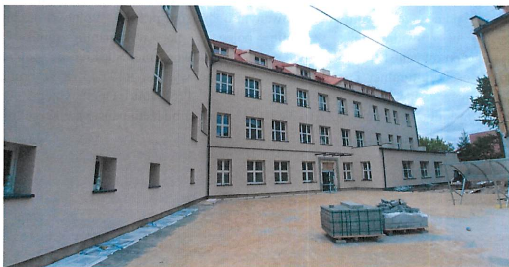
Przebudowa placu przy ul. Powstańców
